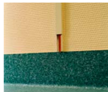
Obr. 4: Vyvedení Cu sběrače na stěnu.
